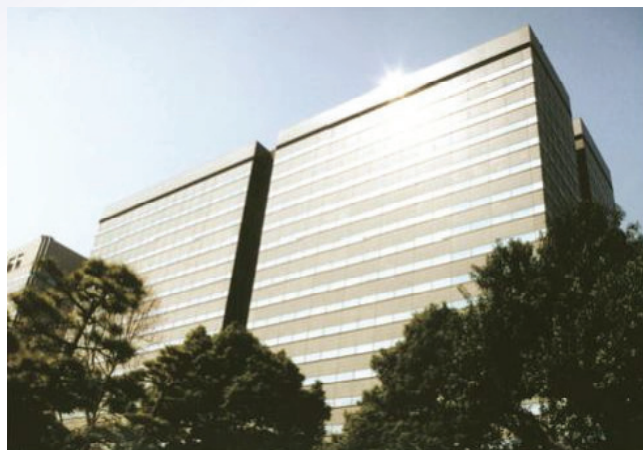
公安調査庁本庁（東京・霞ヶ関，中央合同庁舎6号館）
