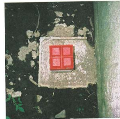
コンクリート杭
