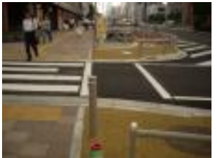
カーブが急な巻き込み部
