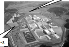
施設全景(完成時)
