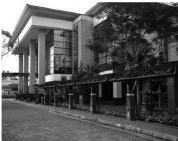
(司法研修所の建物の一部)
