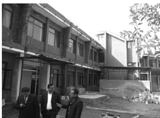
建設中のカトマンズ地検の新庁舎
