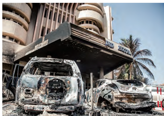
ブルキナファソでのテロ現場(写真提供:EPA =時事)
