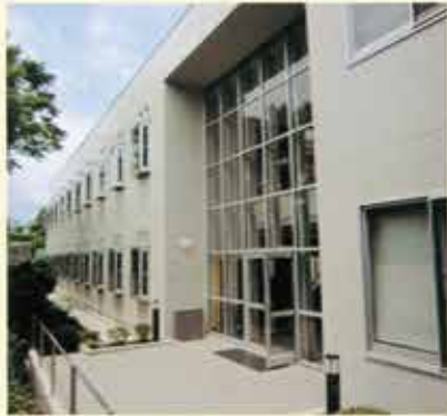
福島自立更生促進センターの外観
