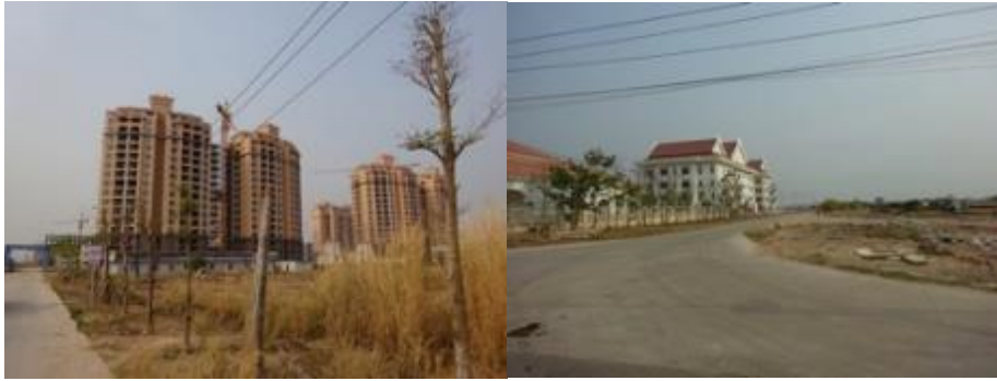
写真 24 新天地内の完成したコンドミニアムと住宅（2016年3月28日撮影）
