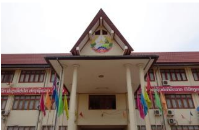
写真 25 スィーコータウン郡の内務局郡事務所
