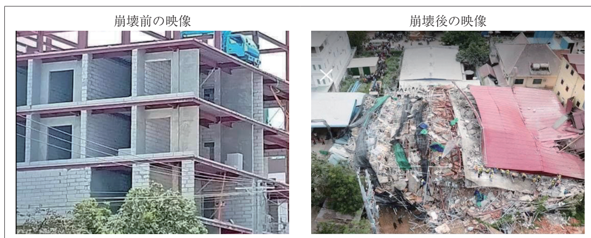
図3：シアヌックビルの建物崩壊事故(2019年6月22日発生)
