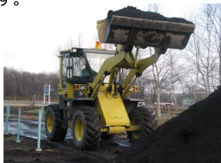
▲土木・建築科
