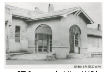
▲昭和18年竣工当時
