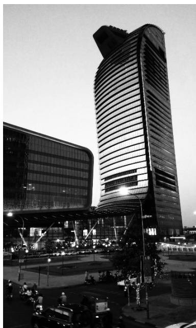
【プノンペン市内の高層ビル】
