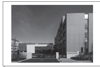
法務総合研究所国際協力部 (国際法務総合センター 国際棟)
