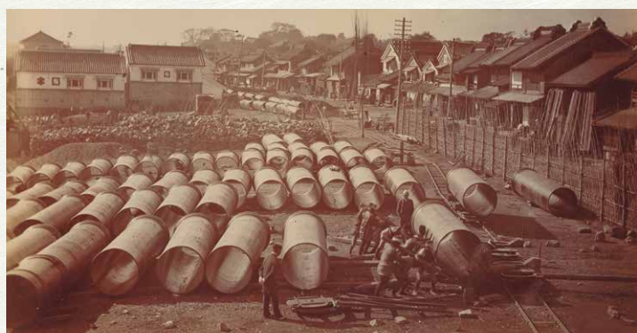
鉄管の搬出(東京都水道歴史館所蔵)
