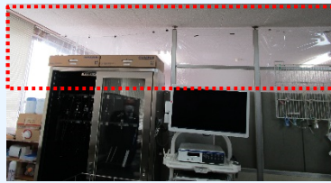
ビニールで空間を仕切っている
