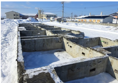
廃庁宿舎の取り壊し作業も進んでいます。
