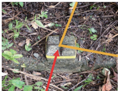
コンクリート杭
