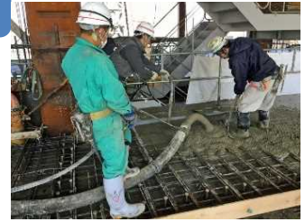
[හැඩයමකට කොන්ක්රීට් වත් කිරීම පිණිස පීඩන පොම්පයක් භාවිතා කිරීම]
