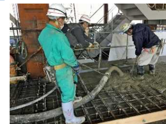
[使用压力泵将混凝土注入模板]
