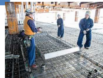
[在钢筋上安装钢模板（左侧为外籍工人）]
