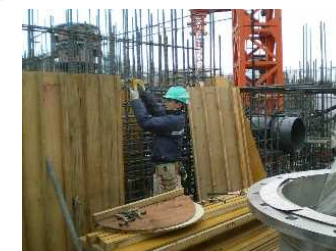
[拼装混凝土浇注模板]
