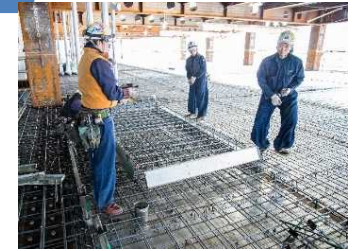
[Pag-mount ng bakal na formwork sa rebar (dayuhang manggagawa: kaliwa)]
