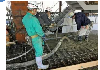
[Paggamit ng pressure pump sa pagbuhos ng kongkreto sa formwork]
