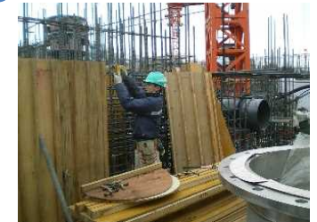
[Pag-aayos ng formwork para sa pagbuhos ng kongkreto]
