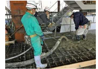
[การใช้ปั๊มแรงดันเพื่อเทคอนกรีตเข้าไปในแบบหล่อ]
