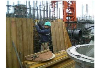
[การประกอบแบบหล่อเพื่อเทคอนกรีต]
