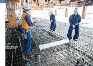
[ติดตั้งแบบหล่อเหล็กบนเหล็กเส้น (คนงานชาวต่างชาติอยู่ด้านซ้าย)]
