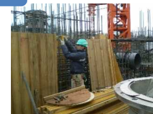
【Hình ảnh công việc ghép Coppapanen để đổ bê tông】
