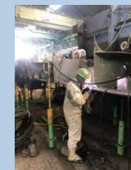
Hình ảnh công việc hàn
